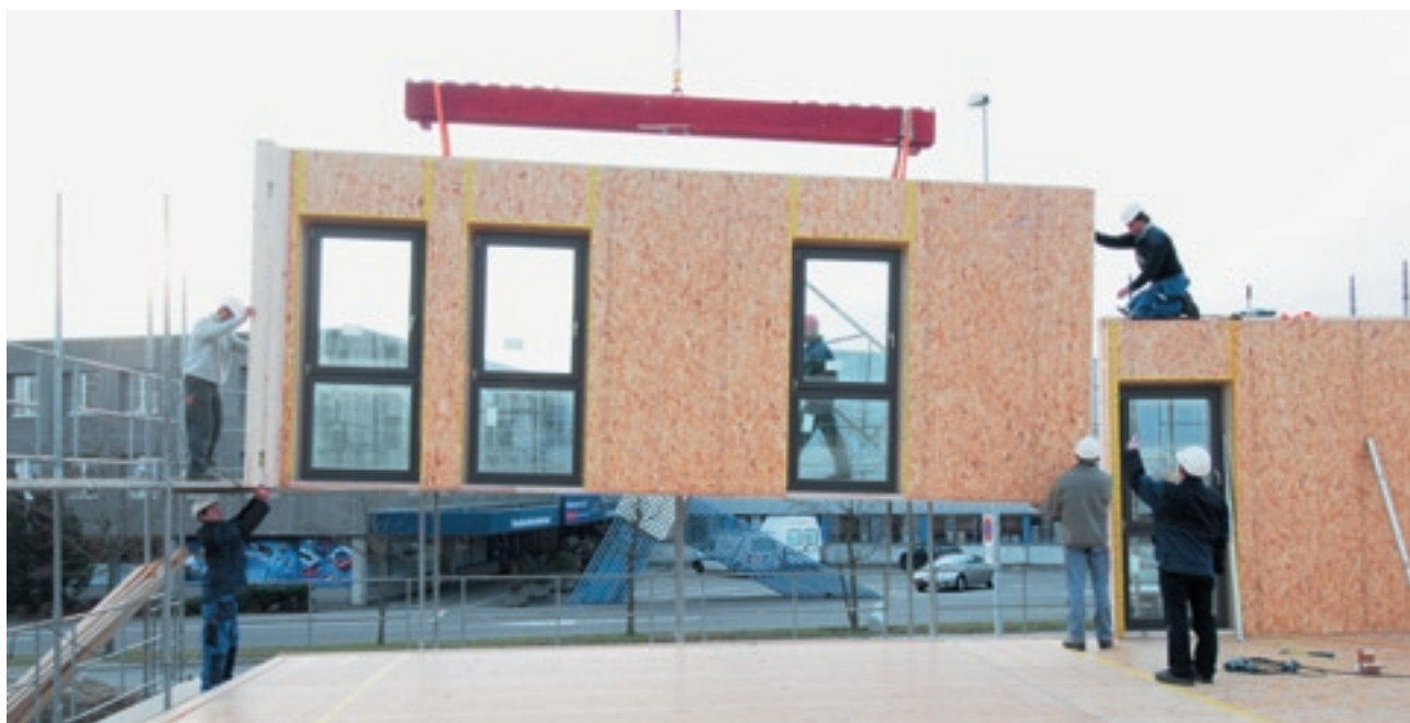
Montage des parois du rez-de-chaussée.
