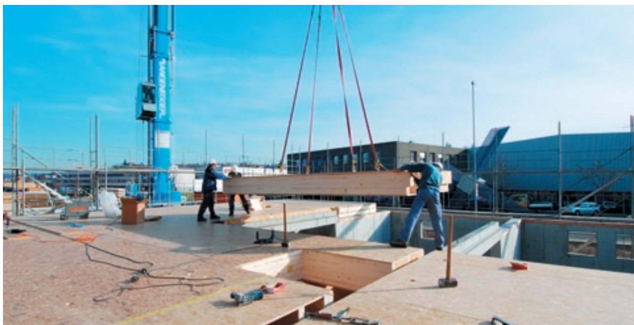
Montage de la dalle du rez-de-chaussée.
