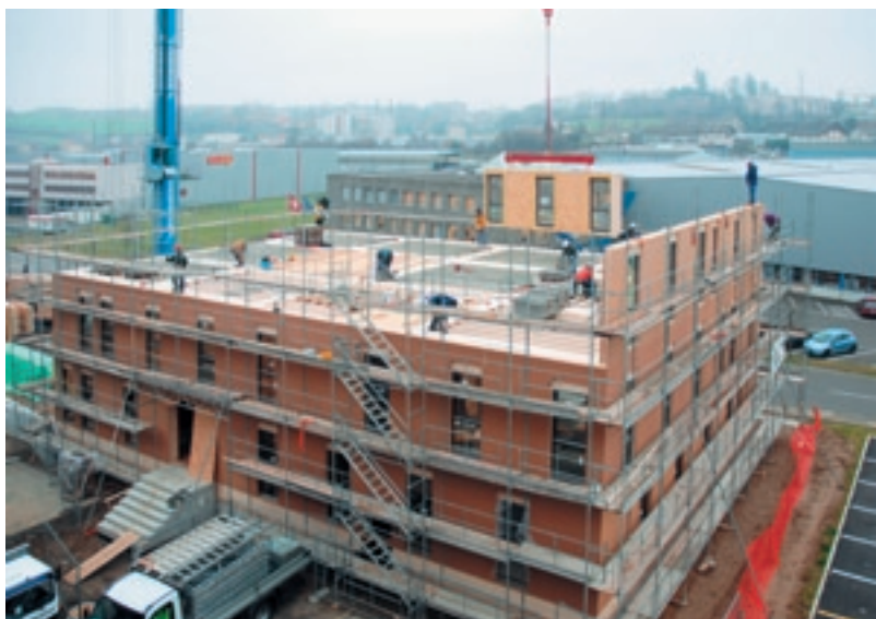
Montage des parois du troisième niveau.
